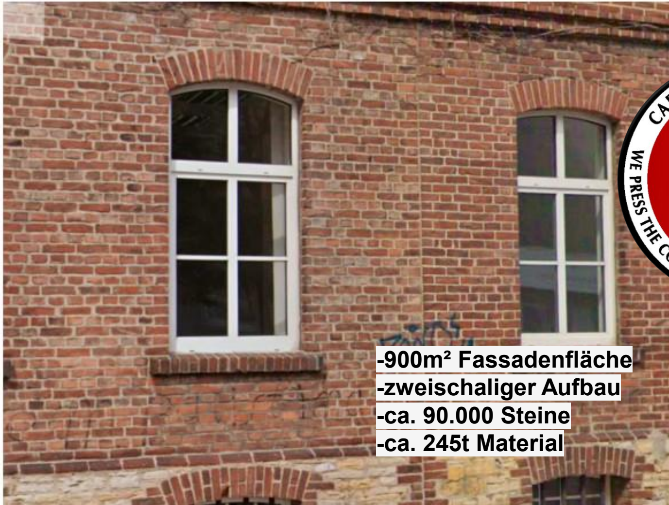
Abb. 1: Ziegelmauerwerk Gebäude Rehmstraße 20
