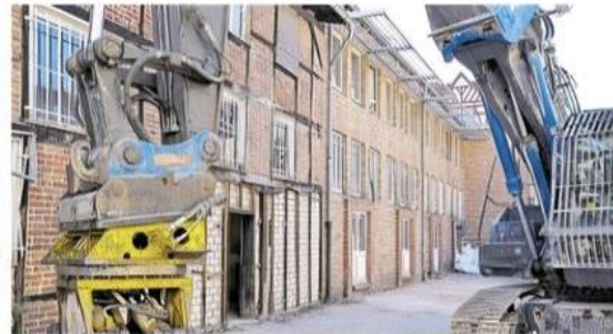
Der Abrissbagger steht bereit.
