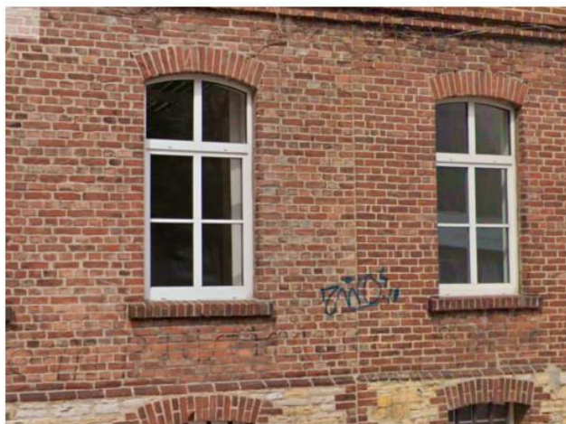
Abb. 1: Ziegelmauerwerk Gebäude Rehmsstraße 20
